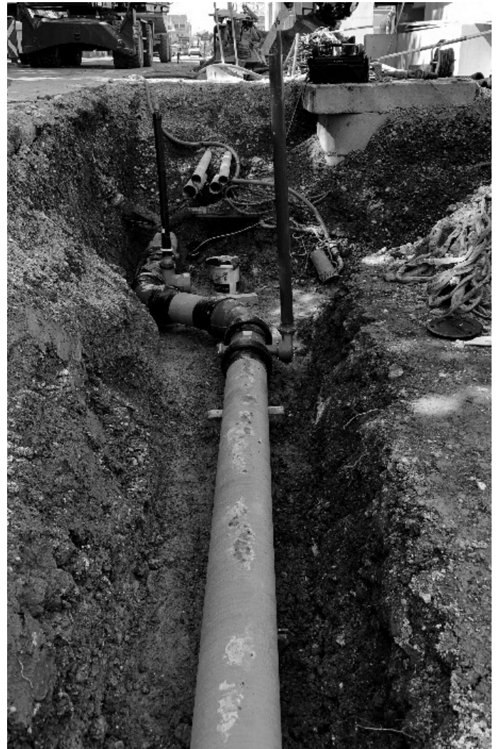
Ersatz der Hauptwasserleitung in Buttikon
