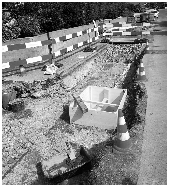
Werkleitungsbau der ersten Etappe an der Ringstrasse
