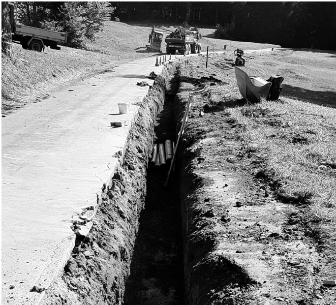
Rohrleitungsbau in der Schwendenen in der kommunalen Schutzzone
