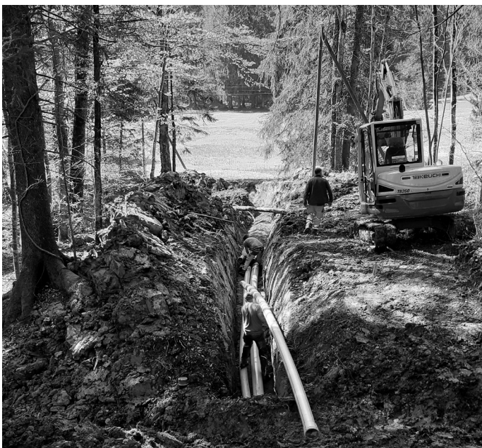
Rohrleitungsbau in der Schwendenen mit Bachunterquerung
