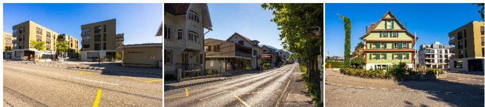
Neue Überbauungen und vereinzelte ältere Bausubstanz entlang der Kantonsstrasse in Buttikon
